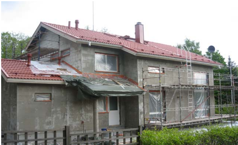
Kuva 3 Pientaloissakin työskennellään vaarallisen korkealla. Putoamissuojauksesta on aina huolehdittava.
